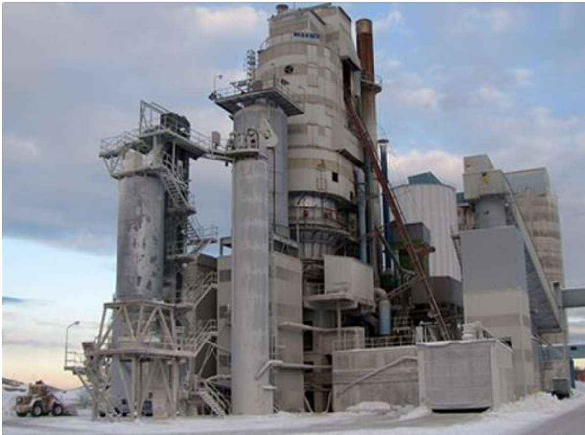
Figur 1. Schaktugn på Nordkalks anläggning på Gotland.
