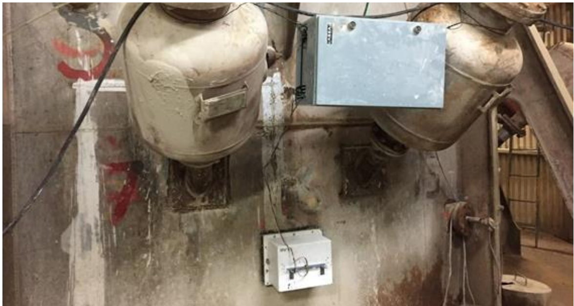
Figur 9. Installation av radiomätutrustning på Nordkalks schaktugn i Storugns, Gotland.
