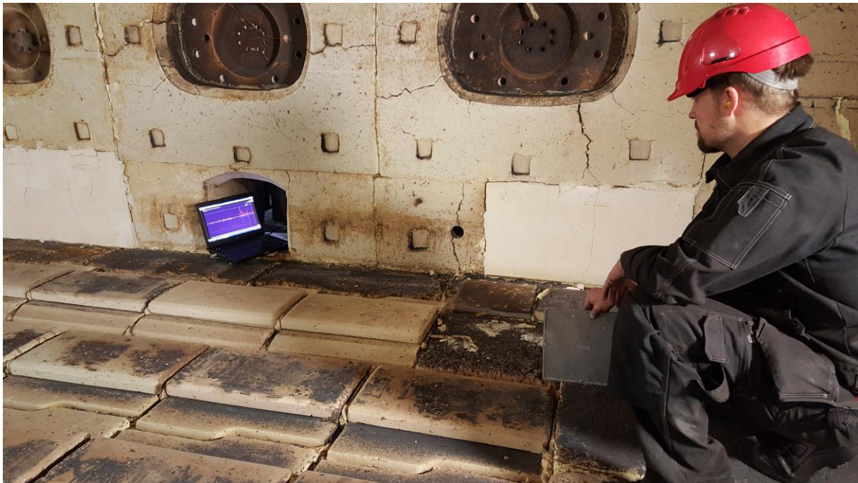
Figur 4.13. Ombyggd ugn (ljusare rektanglar) och provmätning med plåtskiva.
