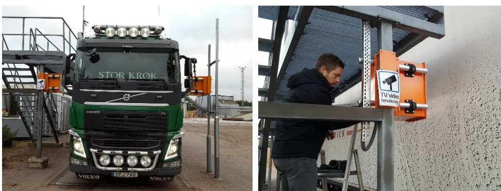
Figur 20. Installation på Johannes bränsledepå av sensorer för radiotransmissionsmätning.
