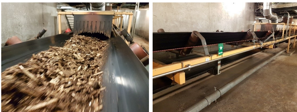
Figur 33. Transportband på Johannes bränsledepå vid Gävle Energi.
